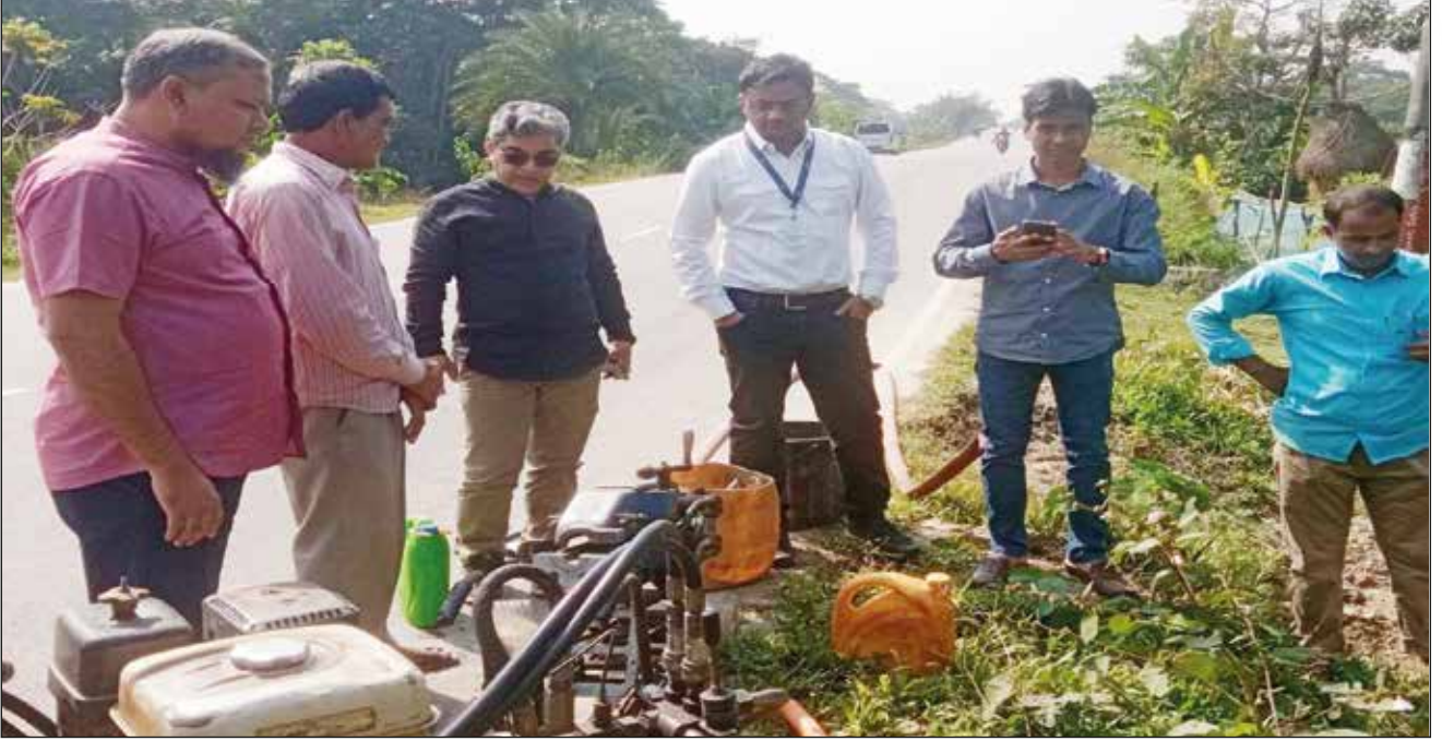
চিত্র ৮.৩: এনটিটিএন কর্তৃক ভূগর্ভস্থ অপটিক্যাল ফাইবার নেটওয়ার্ক স্থাপন কার্যক্রম সরেজমিনে পরিদর্শন
