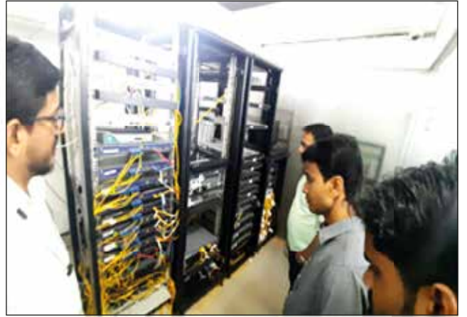
কুমিল্লায় আইএসপি প্রতিষ্ঠানের অফিসে পরিচালিত পরিদর্শন কার্যক্রমের আলোকচিত্র
